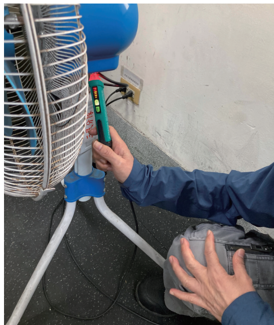
圖 3、電器設備檢測
